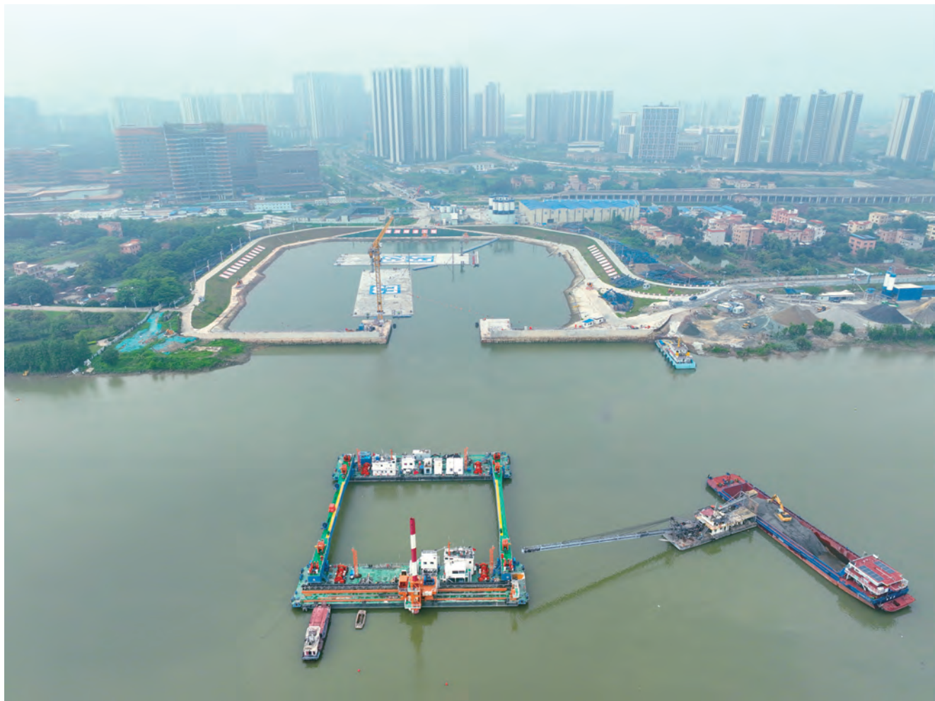
内河沉管整平设备正在施工
