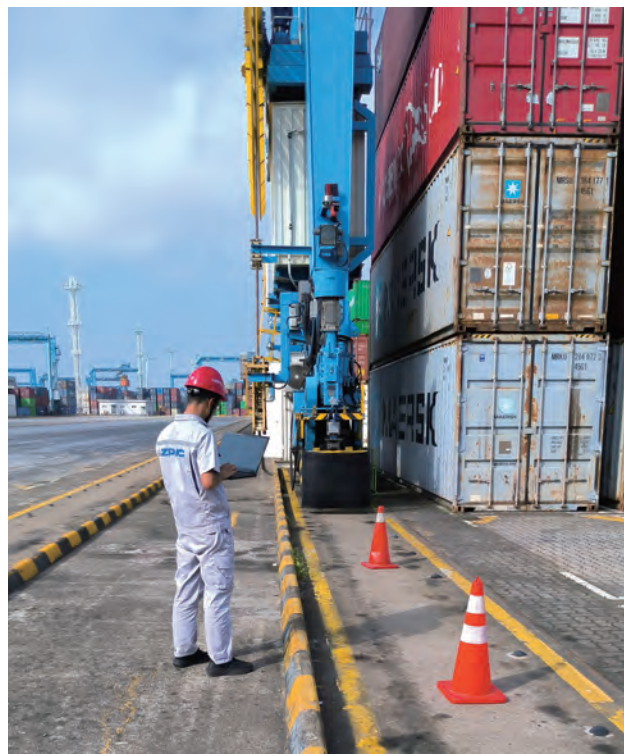
ZPMC 工程师在宁波梅东码头现场调试
