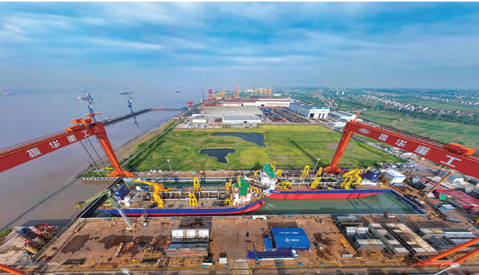
世界领先、亚洲最大的 35000m 3 舱容等级超大型耙吸挖泥船顺利吉水
