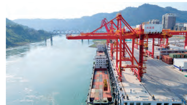
云南水富港岸桥正在作业
