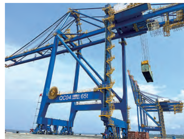
岸桥 8 小时耐久测试中
