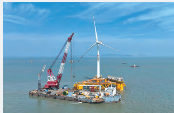
2023年10月，全球首个漂浮式风光渔融合项目“国能共享号”平台主体工程宣告完工
