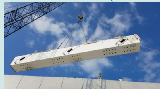
减光罩正在吊装。
